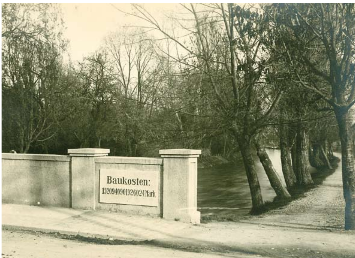
Teuerste Brücke der Welt: Die 1923 gebaute «Billionenbrücke» in Singen. Bilder: zvg
