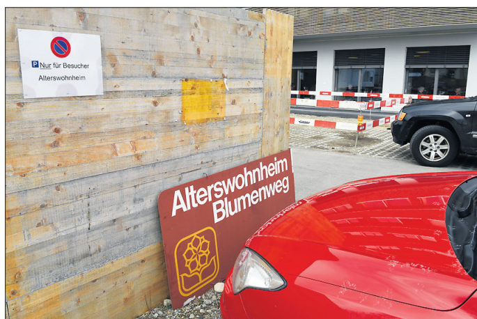
Zurzeit wird das Altersheim umgebaut. Foto: Peter Pfister
