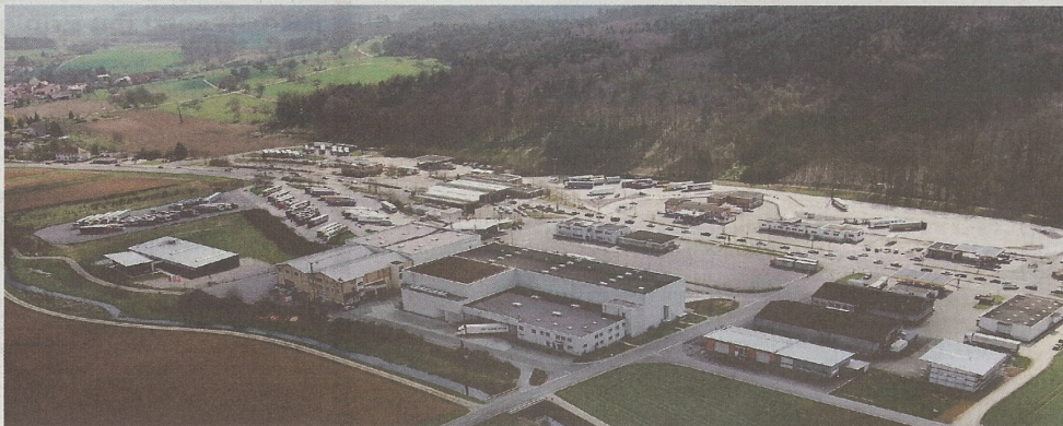
Die Gemeinschaftszollanlage Thayngen-Bietingen ist in den letzten 20 Jahren markant grösser und moderner geworden.
